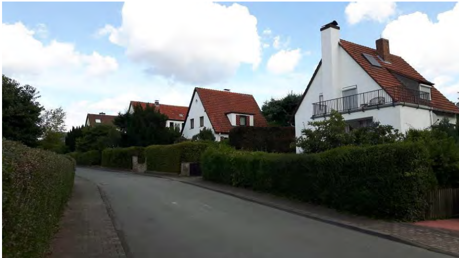
Abbildung 2: Bebauung an der Straße "Helisosteig"
