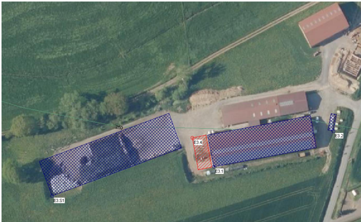
Abbildung 7: Emissionsquellen Betrieb 3, Außenbereich
