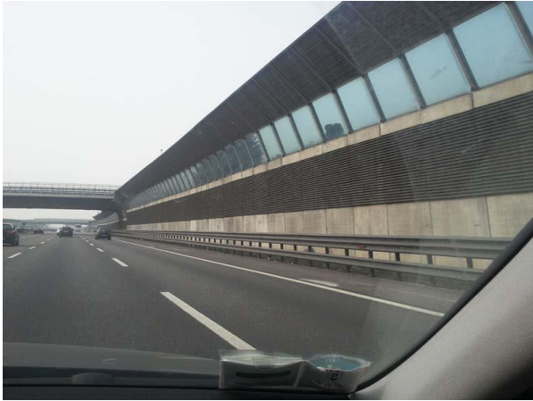
Abb. 6: Abbildung einer abgewinkelten Lärmschutzwand
