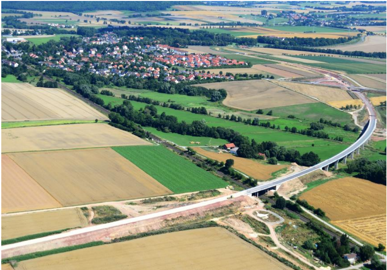
Abbildung 64: Hofgeismar – B 84 – Ortsumgehung [Quelle: Hessen Mobil]
